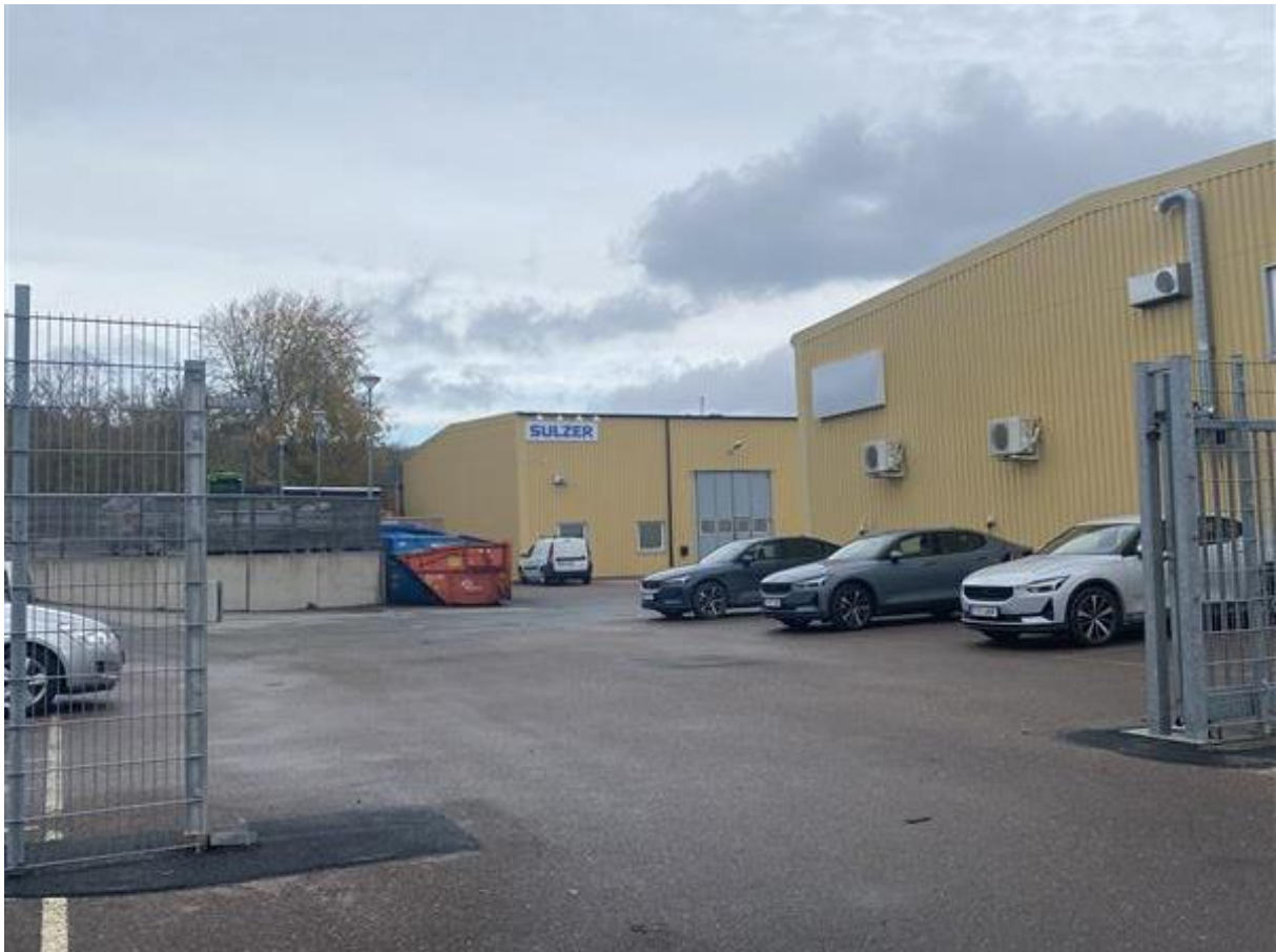
Figur 11: Foto från infarten till fastigheten.
